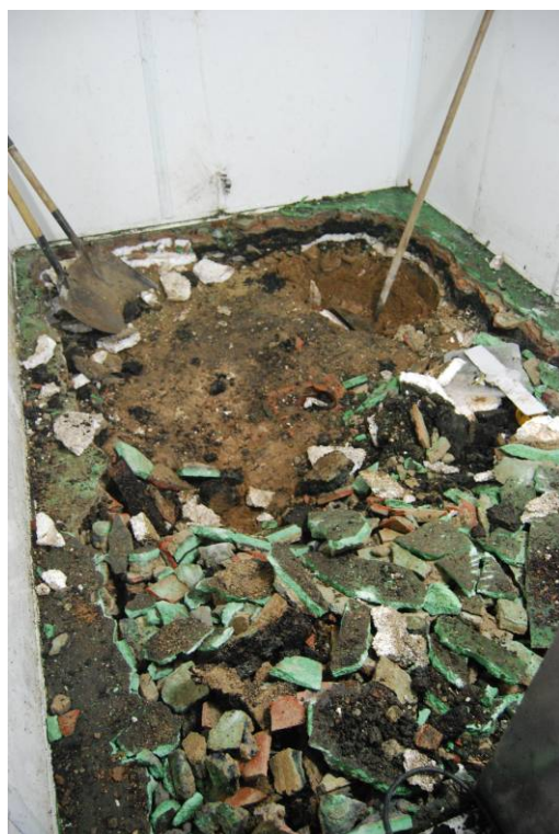
Fotografia núm. 4: desmantellament de la cambra frigorífica
