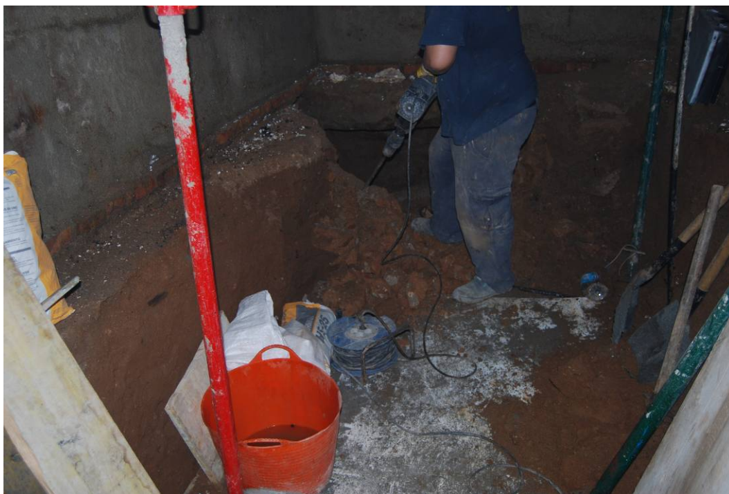
Fotografia núm. 11: desmuntatge de la UE 1002
